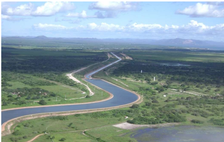
Figura 3 – Conclusão da obra do Eixão das Águas
